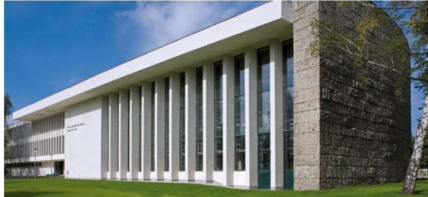
Der außen sanierte Henry-Ford-Bau
