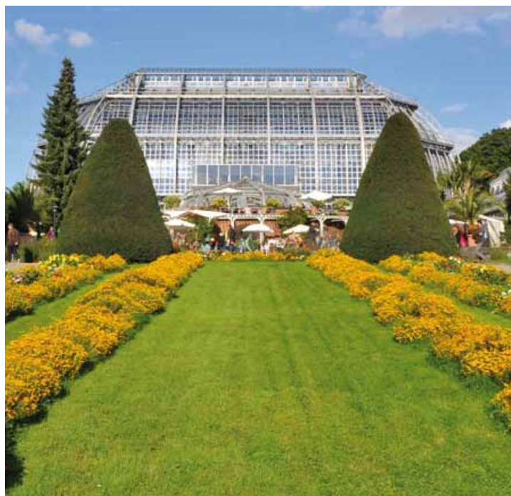
Die Sanierung des Tropenhauses des Botanischen Gartens der Freien Universität senkte dessen Energieverbrauch um die Hälfte.
