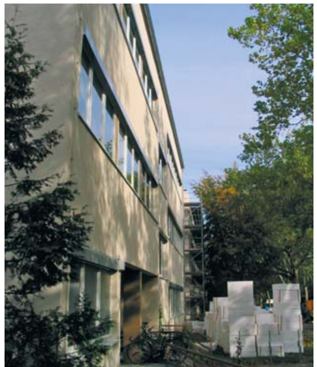
Das Institutsgebäude Arnimallee 3-7 während der Sanierung der Gebäudefassade
