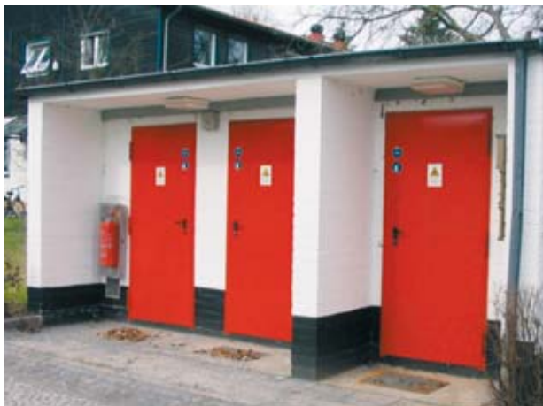
Gefahrstofflager der Klinik für Kleintiere
