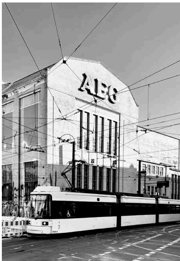
Elektropolis, AEG in Oberschöneeweide. Das ehemalige Transformatorenwerk in der Wilhelminenhofstraße gehörte seit 1920 zur AEG.
