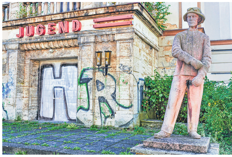
Achtung, Achtung, in Brandenburg wird die Jugend gesucht. Sie wurde zuletzt an dieser überwucherten Bauruine gesehen.
